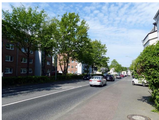
Bardenberger Straße, Kreisverkehr Richtung Zentrum
