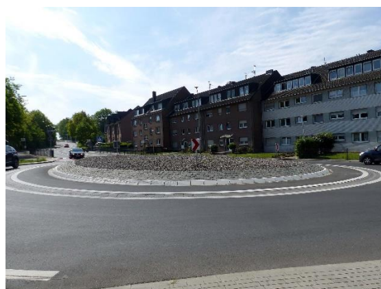
Bardenberger Straße, Kreisverkehr Richtung Ortsausgang
